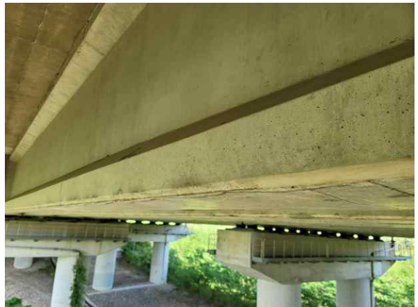
PSC Girder 전경
