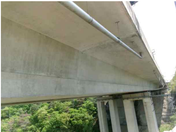
PSC BOX 외부 전경
